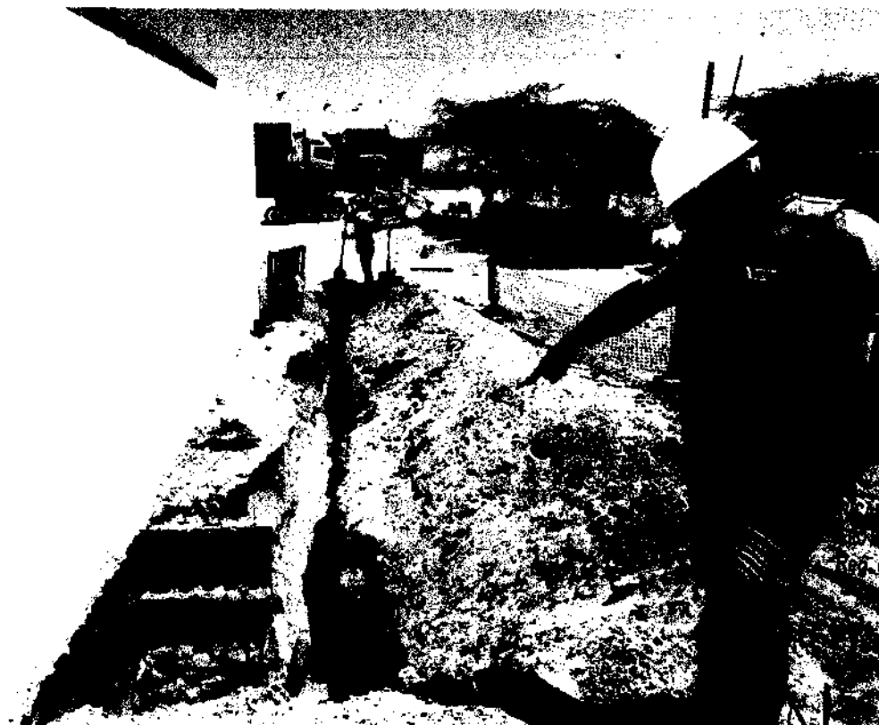
BUZONES DE CONCRETO DE 1.00x1.00x1.55m (LADO x LADO x PROF.)
